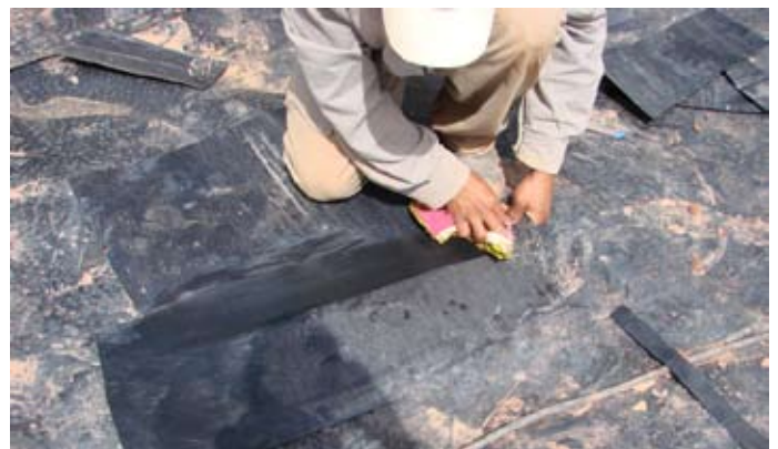
Figura 03. Limpeza da superfície.
