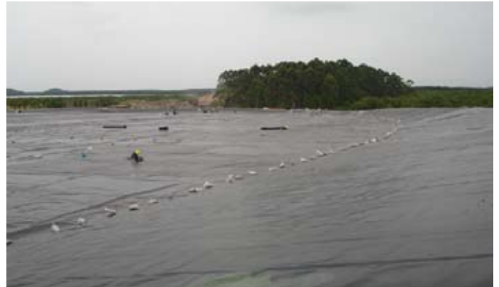
Figura 01. Fixação provisória dos painéis com sacos de areia.
