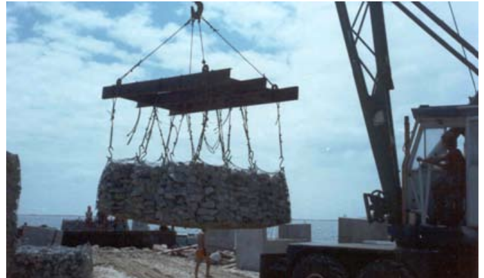
Figura 01. Gabião caixa içado com o auxílio de guindaste.
