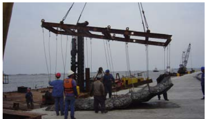
Figura 02. Detalhe do içamento do colchão Reno com destaque para o balancim.
