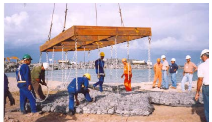
Figura 03. Colchão Reno içado com auxílio do balancim.
