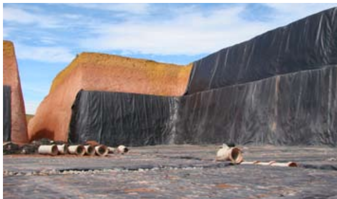
Figura 02. Revestimento de aterro sanitário com geomembranas (e levada sobrecarga).
