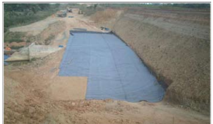
Figura 3 – Aplicação de geotêxtil entre camadas de um pavimento em construção.
