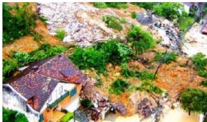
Figura 04. Deslizamento de solo.
