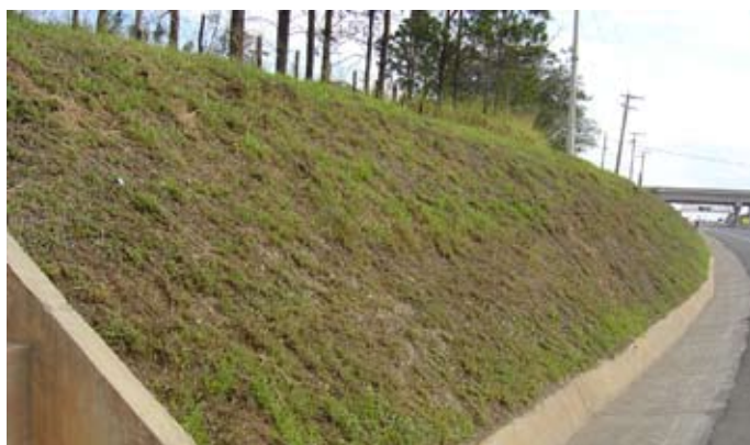
Figura 03. Vegetação desenvolvida sobre o talude revestido.
