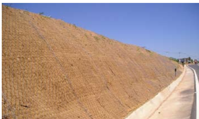
Figura 02. Talude revestido com biomantas BioMac®.
