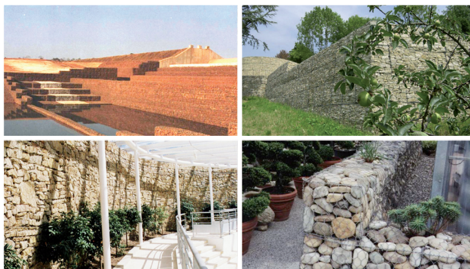
Figura 1 - Variabilidade das estruturas em gabiões.
