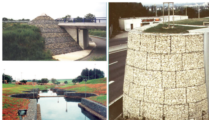
Figura 2 - Construções com formatos e volumes diversos.
