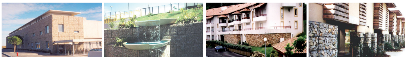
Figura 3 - Variabilidade das estruturas em gabiões.
