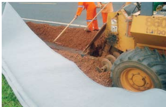
Durante a obra
