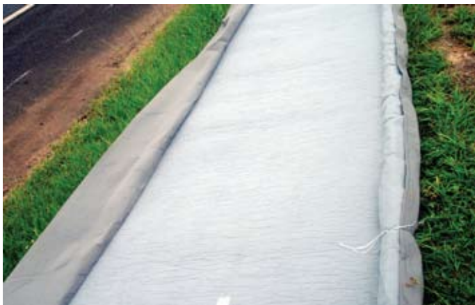
Durante a obra
