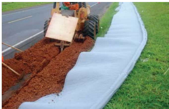
Durante a obra
