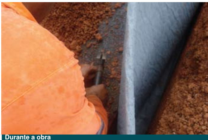
Durante a obra
