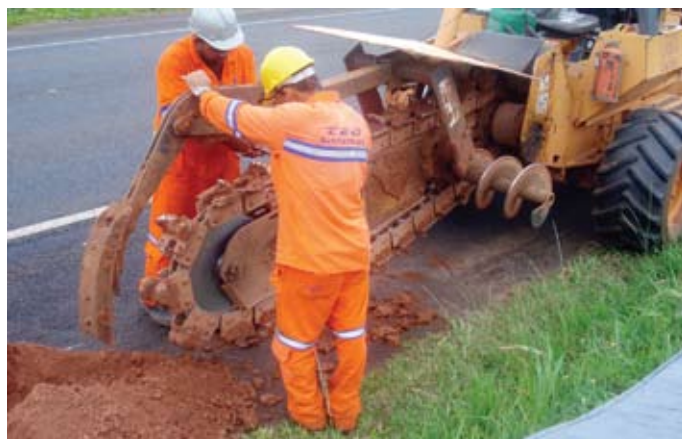
Durante a obra
