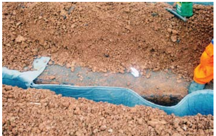
Durante a obra
