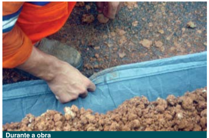
Durante a obra
