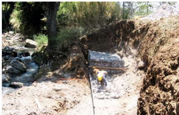
Durante a obra
