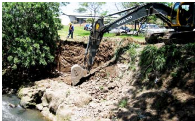
Durante a obra
