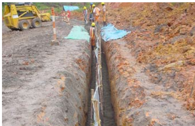
Durante a obra
