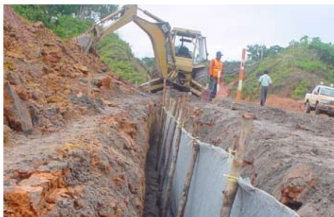
Durante a obra
