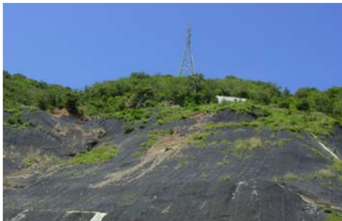
Figura Y – Revestimento de talude extenso com MacMat® R
