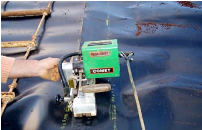
Durante a obra
