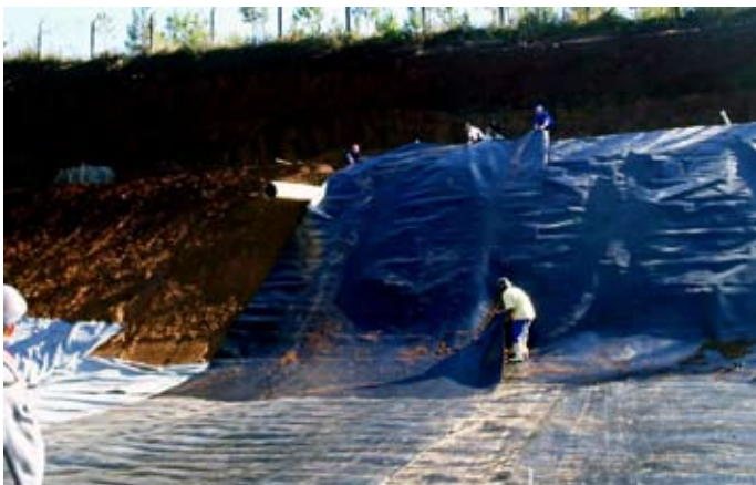
Durante a obra
