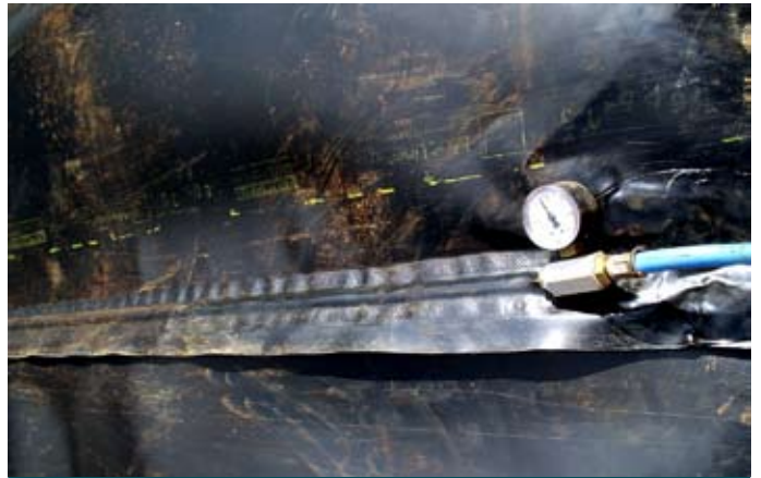
Durante a obra
