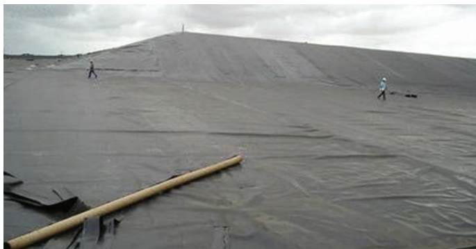
Foto 01 - Geomembrana MacLine® aplicada em aterro de resíduos.
