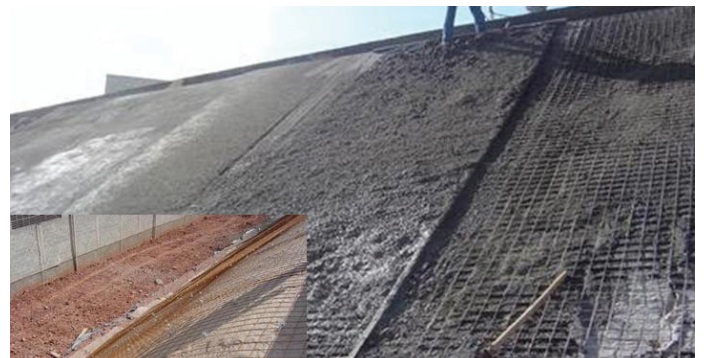
Foto 02 - Aplicação de geocomposta para drenagem MacDrain®.
