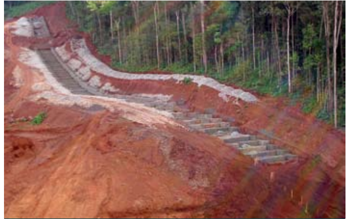
Durante a obra
