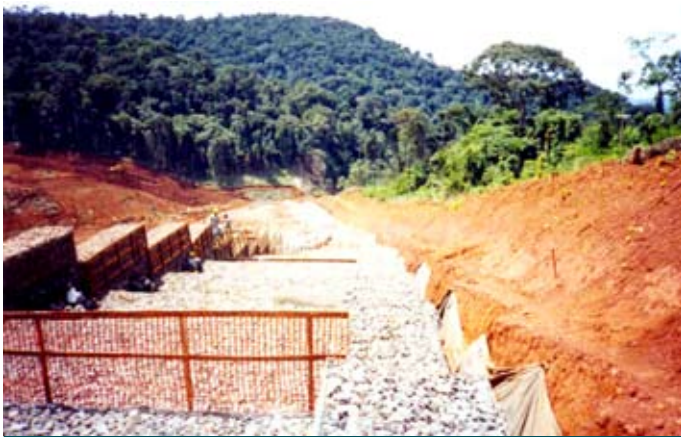
Durante a obra
