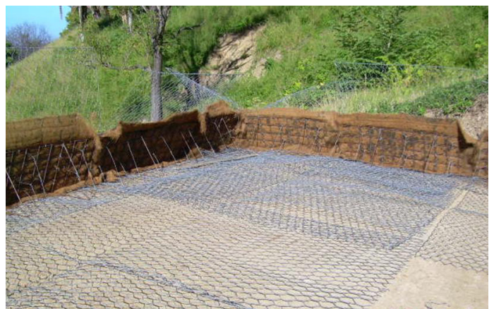
Foto 01 - Obra em andamento
