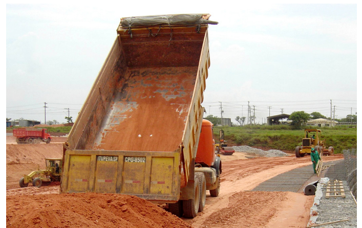
Foto 02 - Obra em andamento
