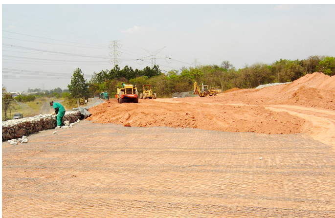
Foto 01 - Obra em andamento
