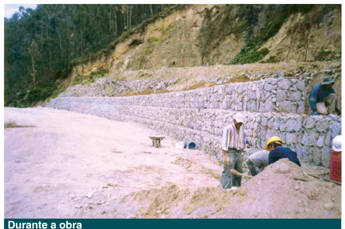
Durante a obra
