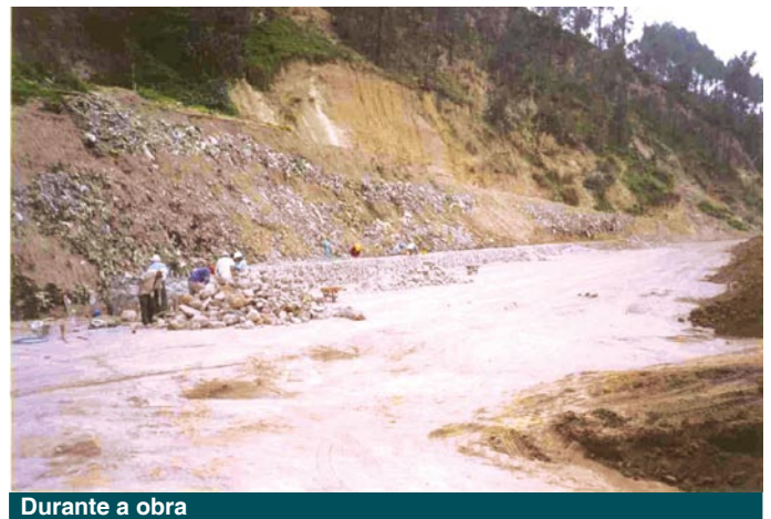
Durante a obra
