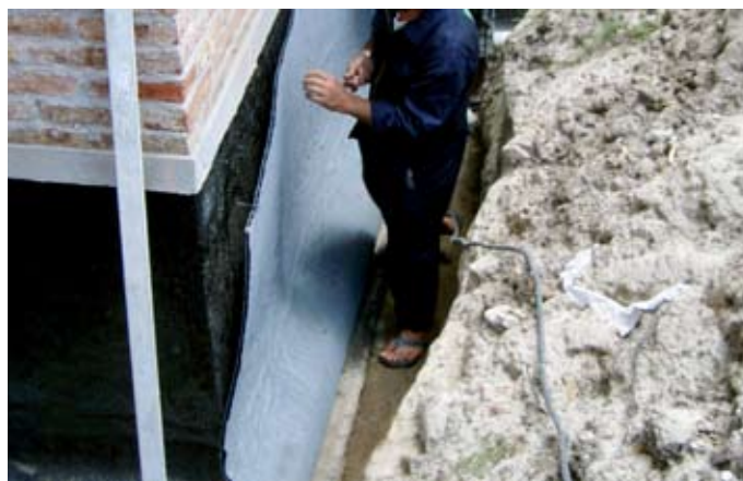
Durante a obra
