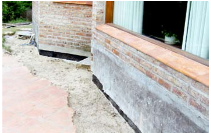
Durante a obra
