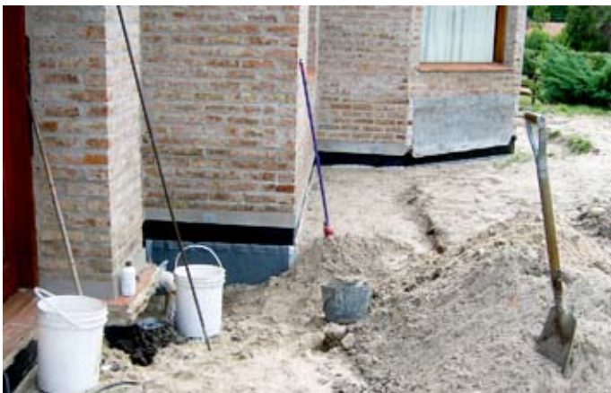
Durante a obra
