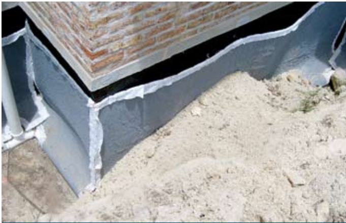
Durante a obra
