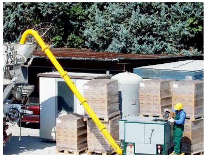
02 - Transporte automático de fibras até a betoneira
