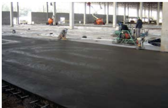
Durante a obra
