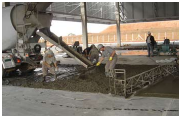
Durante a obra
