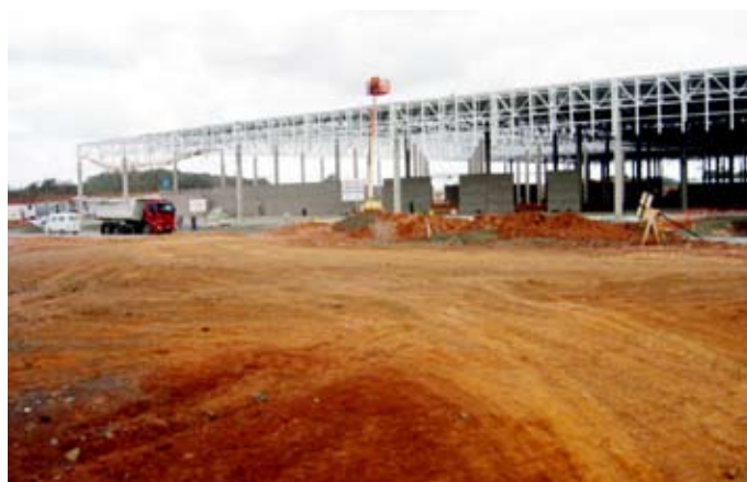
Durante a obra
