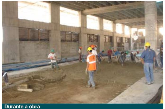
Durante a obra
