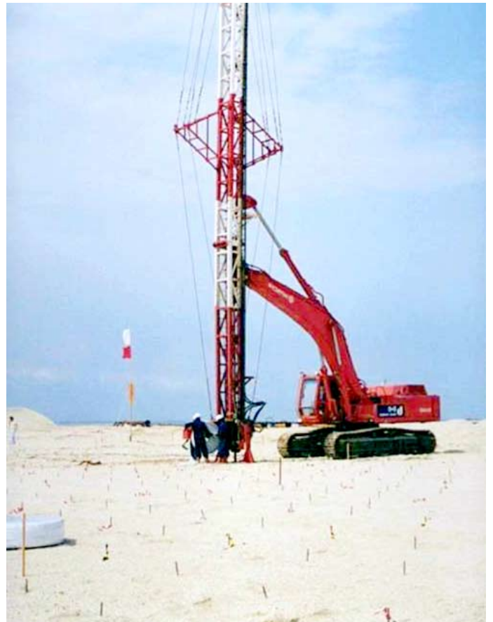
Equipamento de cravação
