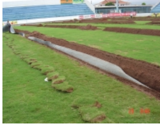
Foto 2. Trincheira com profundidade máxima de 1.00m
