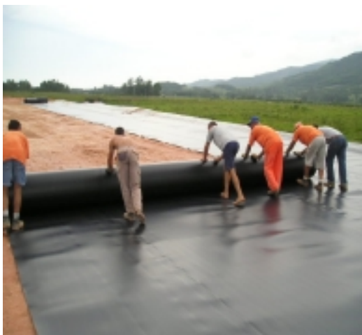
Figura 2 – Instalação da geomembrana
