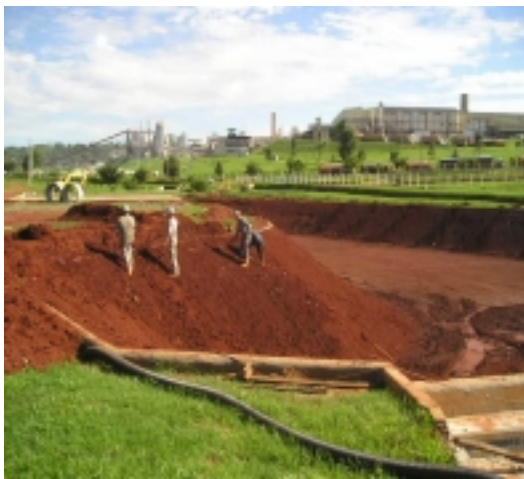
Figura 1 - Preparação do terreno
