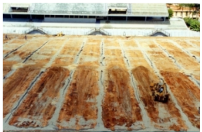
Durante a construção
