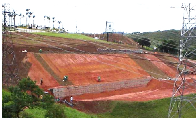
Depois da Construção
