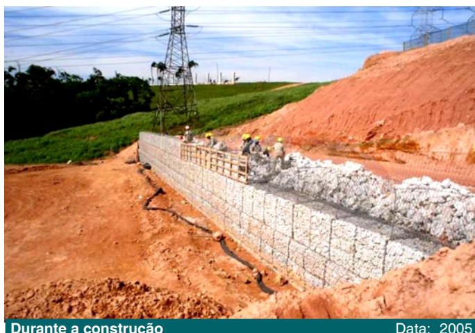
Durante a construção
