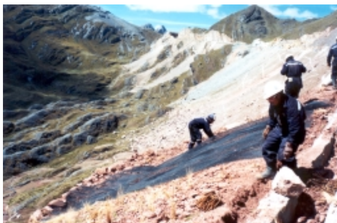
Durante a Construção
