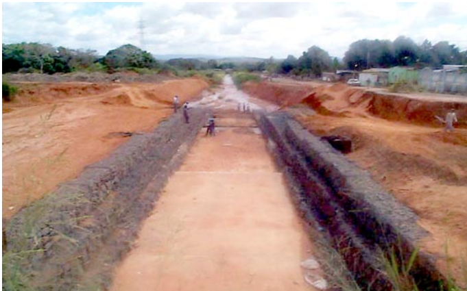
Durante a Obra
