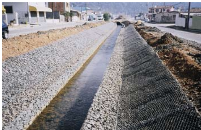
Durante a Construção
