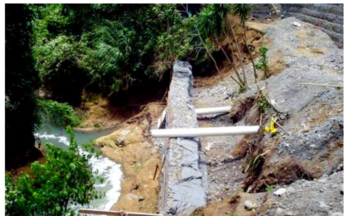
Durante a Construção
