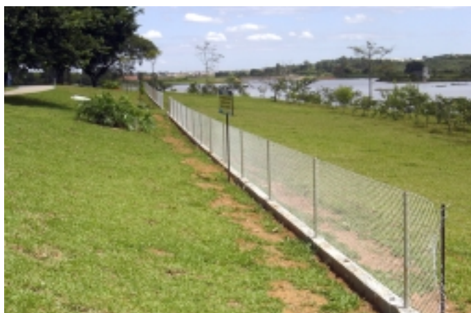
Durante a Construção
