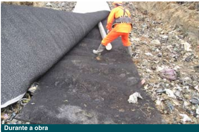
Aplicação da geomembrana
