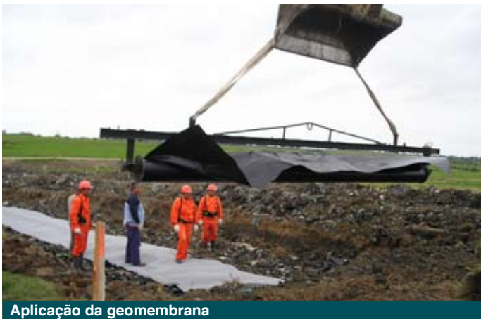
Aplicação da geomembrana
