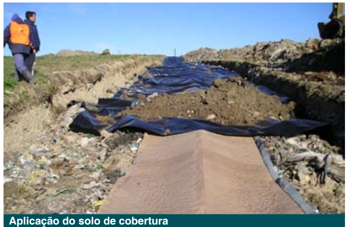
Aplicação do solo de cobertura
