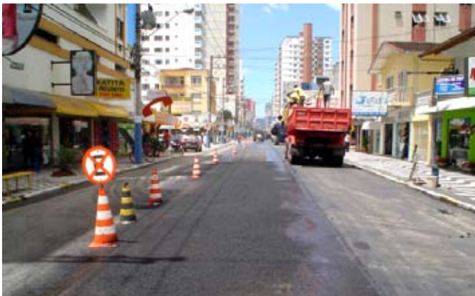
Durante a Construção
