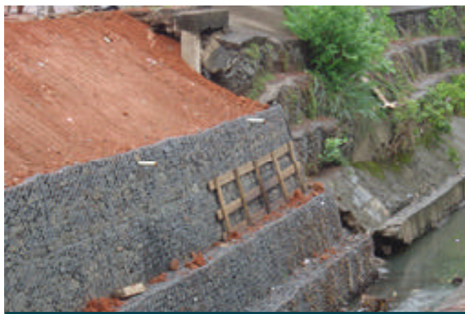
Durante a construção
