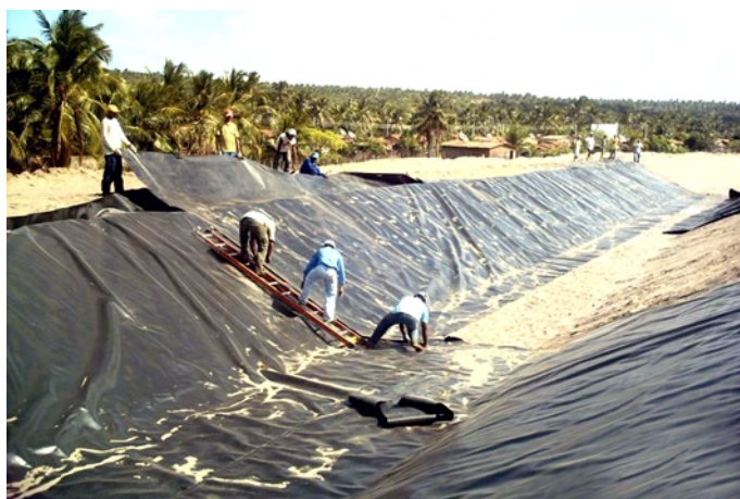
Durante a construção
