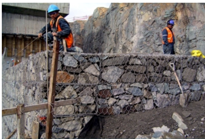
Durante a Construção
