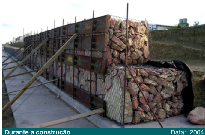
Durante a construção
