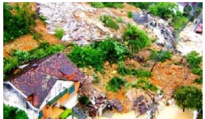
Figura 04. Deslizamiento de suelo.
