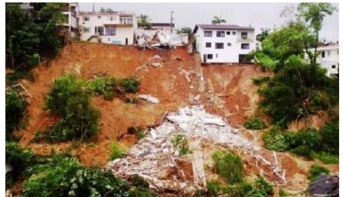
Figura 03. Deslizamiento de suelo.
