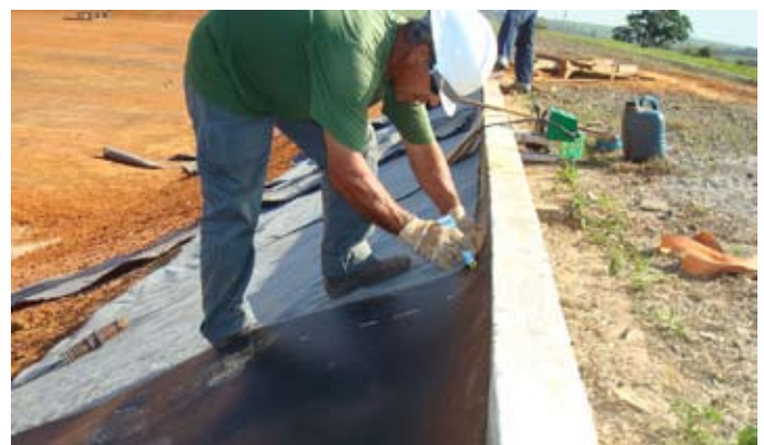
Figura 02. Marcación de los traslapes mínimos.
