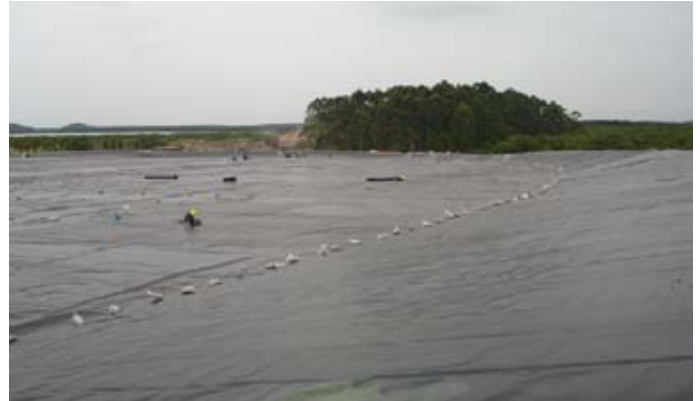
Figura 01. Fijación provisoria de los paneles con sacos de arena.
