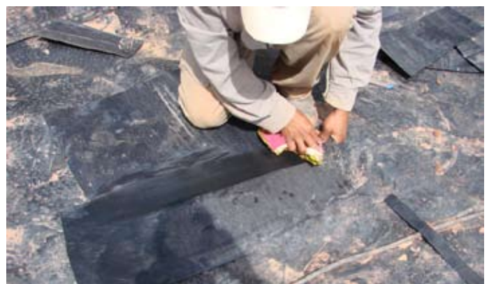
Figura 03. Limpieza de la superficie.
