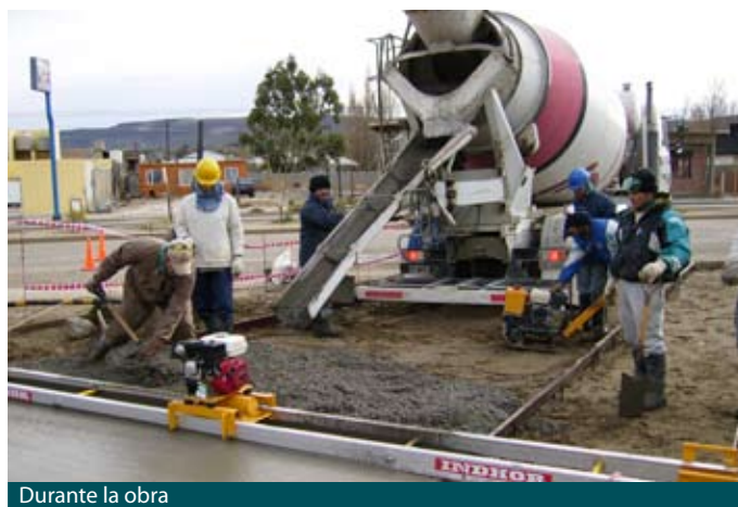
Durante la obra
