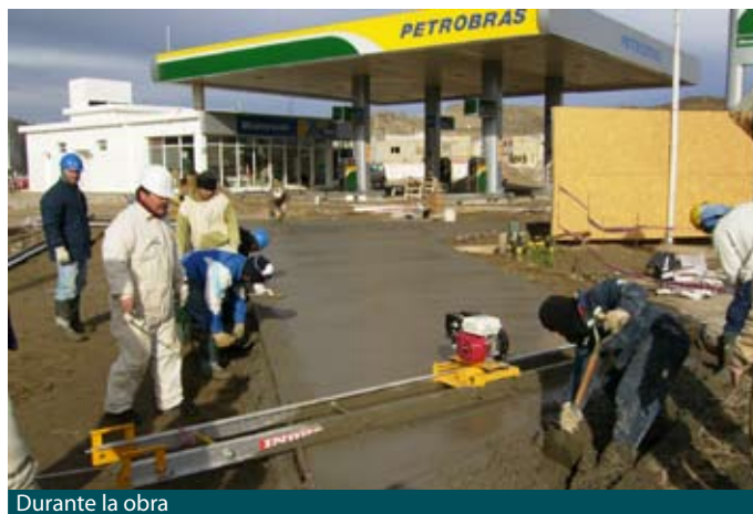
Durante la obra
