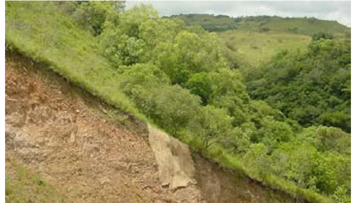
Figura 01. Erosión en talud desprotegido.
