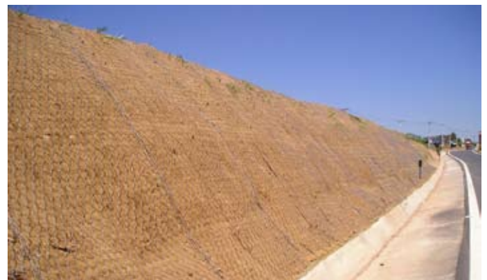
Figura 02. Talud revestido con biomantas BioMac®.
