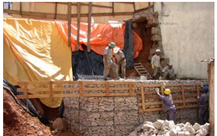
Durante la obra
