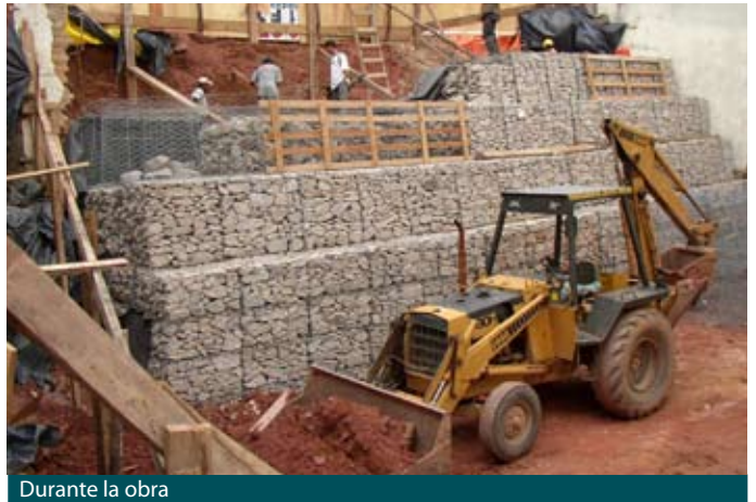
Durante la obra
