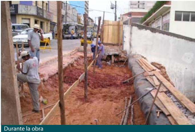
Durante la obra
