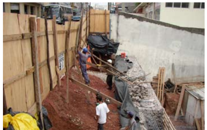
Durante la obra
