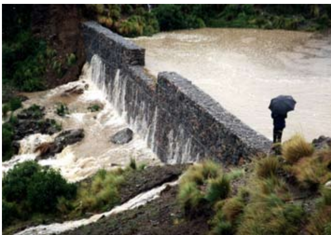
Figura 2 – Barrera construida con Gaviones.
