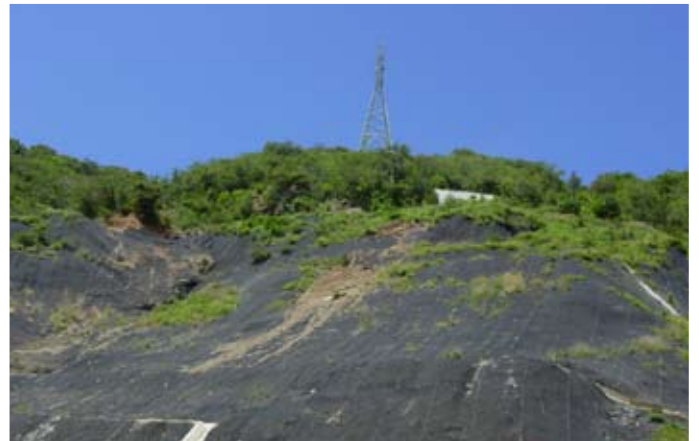
Figura 02 – Revestimiento de talude extenso com MacMat® R
