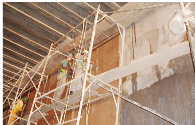
Durante la obra
