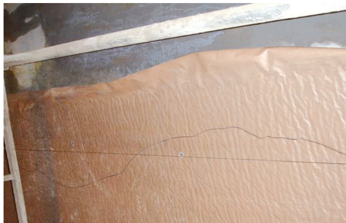
Durante la obra
