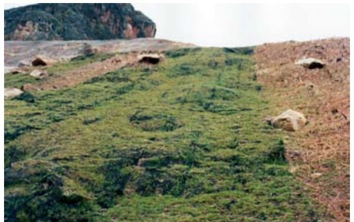
Obra concluída - Junio/2002.
