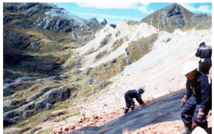
Durante la obra
