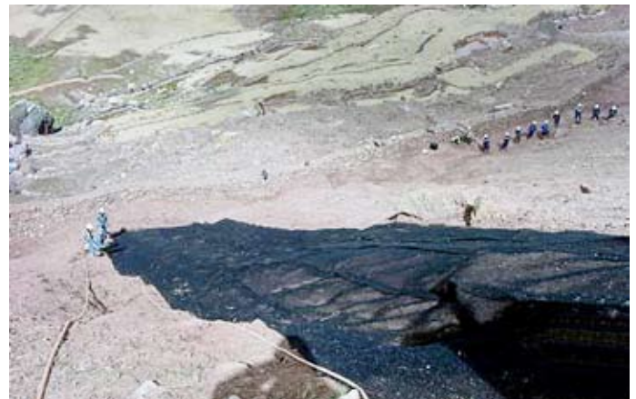
Durante la obra
