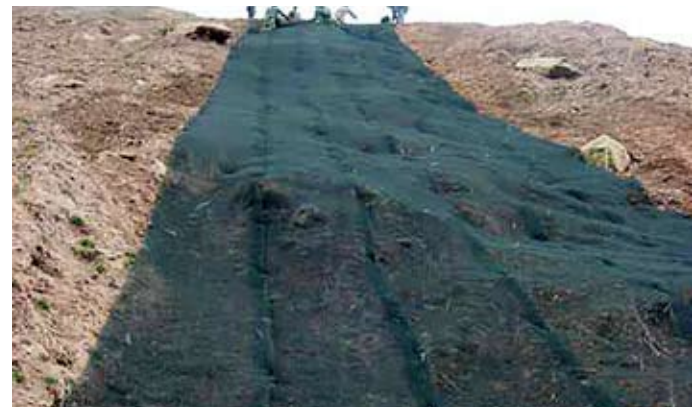
Durante la obra
