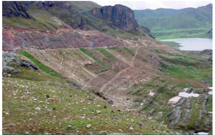
Obra concluída - Junio/2002.
