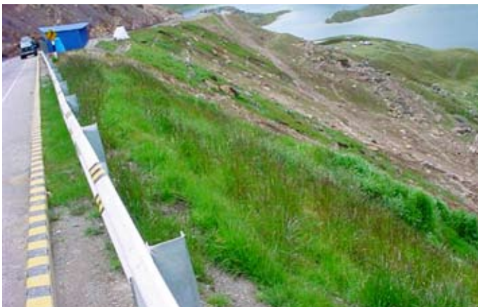
Obra concluída - Junio/2002.
