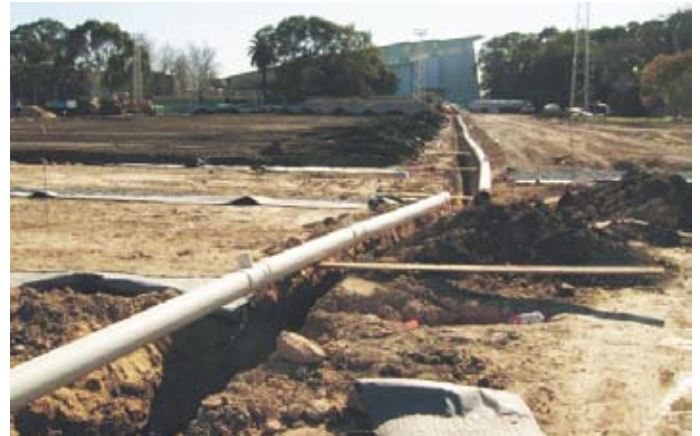
Durante la obra
