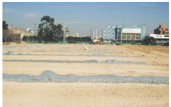
Durante la obra
