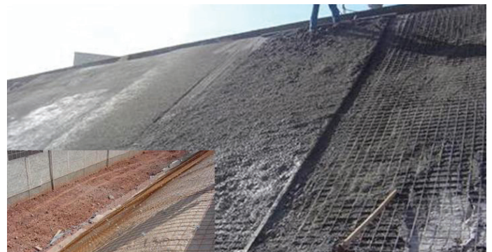
Foto 02 - Aplicación de geocompuesto para drenaje MacDrain®.
