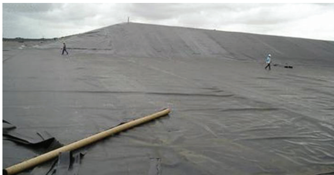
Foto 01 - Geomembrana MacLine® aplicada en terraplén de residuos.
