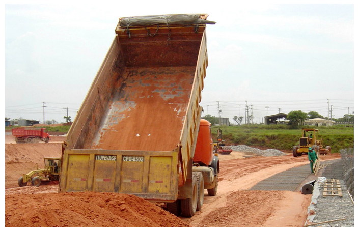
Foto 02 - Obra en construcción
