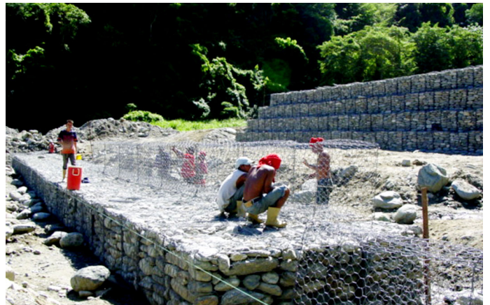
Durante la obra
