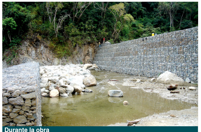
Durante la obra
